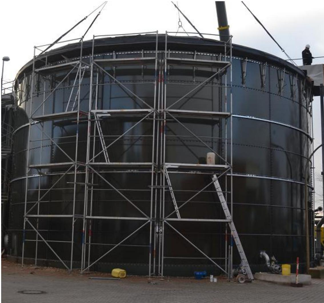
Bilduntertitel: Letzte Schritte bis zur Fertigstellung: Das Dach wird aufgelegt.
